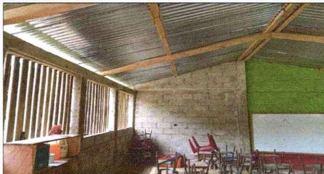
Foto 2: Sustitución de lamina de baja calidad, por lamina troquelada Aluzinc, AULA 1 DE PREPRIMARIA
