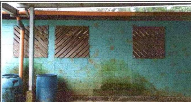
Foto 10: Sustitución e instalacion de balcones de 2.10 x 1.10 METROS ,
