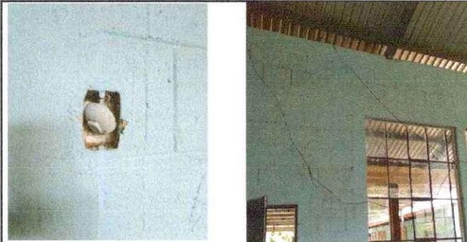
Foto 8: Cambio de sistema eléctrico, sustitucion de cableado electrico y plafoneras.
