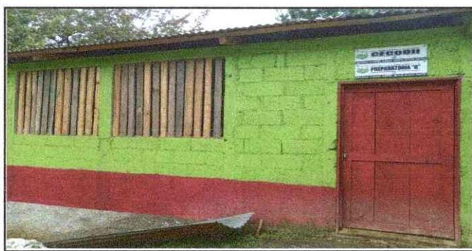
Foto 5: Sustitución e instalacion de puerta de madera por metal, 2.10 x 1 m.
