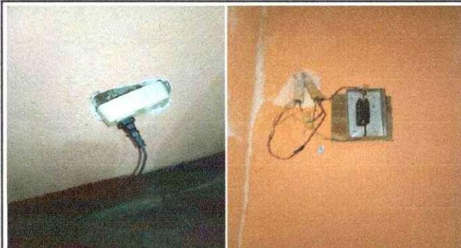
Foto 7: Cambio de Sistema eléctrico, sustitucion de caja de registro de filipones monofasico y tomacorrientes
