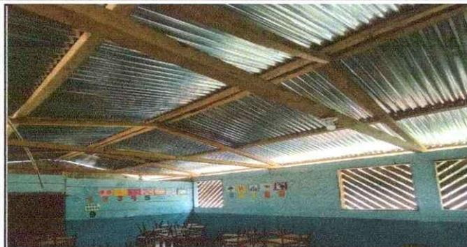
Foto 1: Sustitución de lamina de baja calidad, por lamina troquelada aluzinc, AULA 2 DE PREPRIMARIA.
