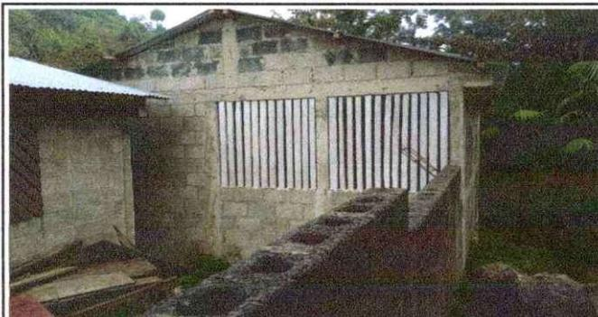
Foto 9: Sustitución e instalacion de ventanas de madera por metal mas vidrio 2.4 x 1.6 METROS , grosor de vidrio 5mm
