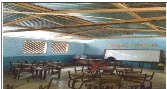
Foto 3: Sustitución de estructura de soporte de madera, por metal, Tubo cuadrado 4x4, chapa 14, AULA 2 DE PREPRIMARIA
